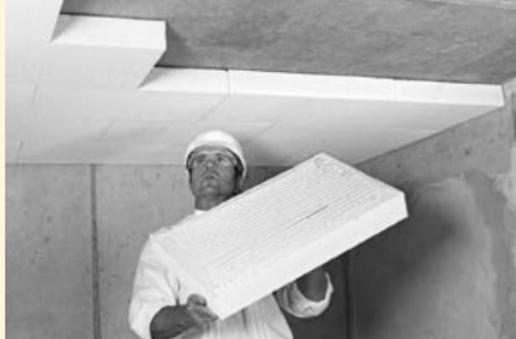
**Vollflächige Verklebung der Ytong Multipor Mineraldämmplatten bei der Deckendämmung**
