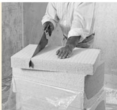
**Passtücke werden einfach und genau mit einer Handsäge oder anderem baustellenüblichen Werkzeug zugeschnitten**
