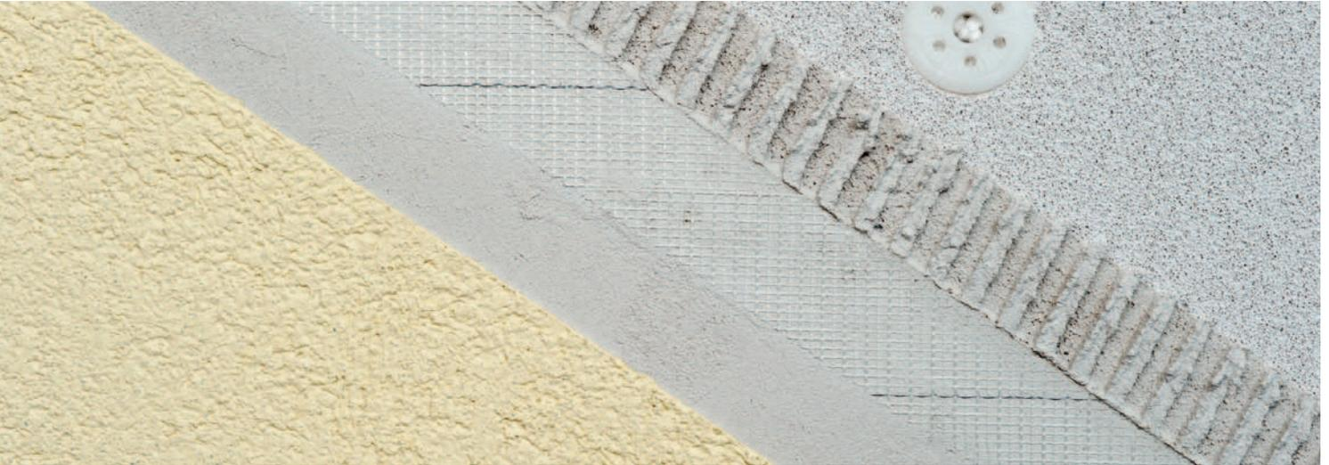
Das Ytong Multipor Wärmedämm-Verbundsystem verfolgt einen ganzheitlichen Ansatz. Alle Komponenten sind perfekt aufeinander abgestimmt und bieten so höchste Systemsicherheit. Die mineralischen Baustoffe sind bauaufsichtlich zugelassen und schaffen Schicht für Schicht einen lückenlosen, diffusionsoffenen Wärmeschutzmantel rund ums Haus.
