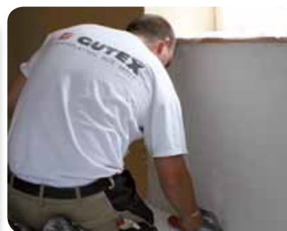
GUTEX Feinspachtelputz für tapezierfähigen Untergrund auftragen
