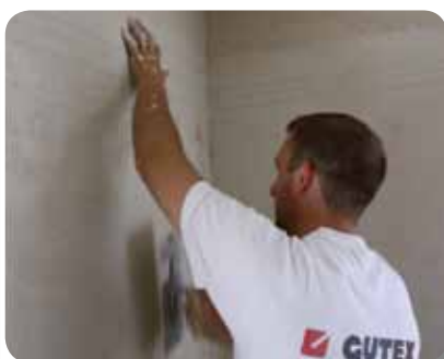
Das GUTEX Universal Armierungsgewebe vollflächig einbetten
