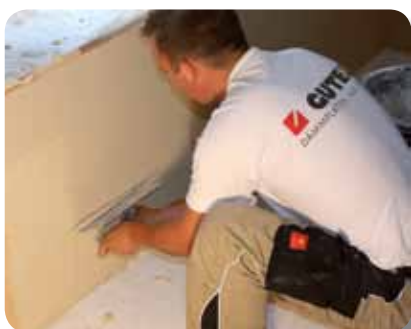
Mit GUTEX Klebe- und Spachtelputz wird der Grundputz hergestellt
