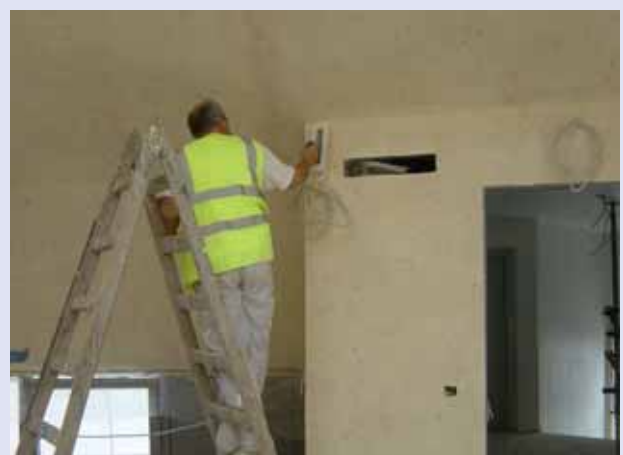
Faserputze aus Baumwolle, Glättetechnik
