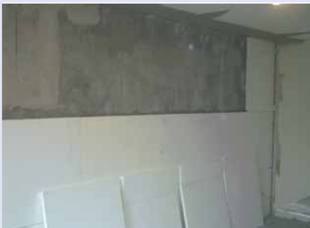
Sanierung eines Dämmschadens mit rein mineralischen Dämmplatten
