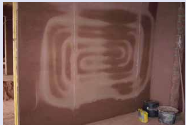
Wandheizung auf OSB mit Lehm verputzt
