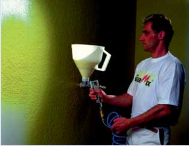
Faserputze aus Baumwolle, Spritztechnik
