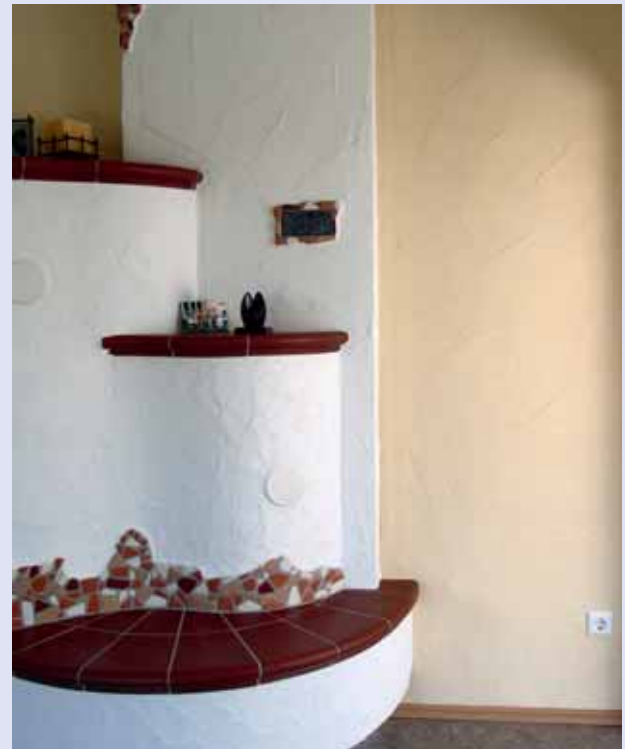
Ofen und Wand mit Kalkputz
