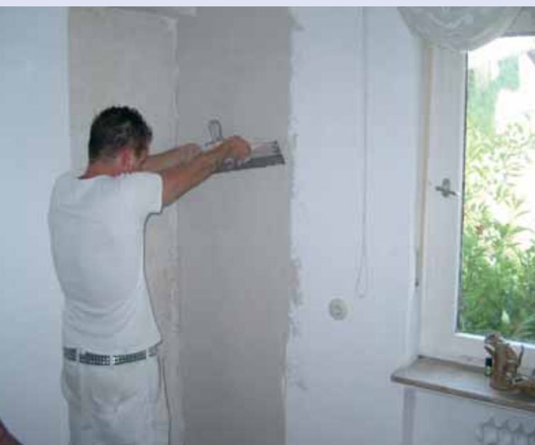
Kalkdämmputz nach Sanierung
