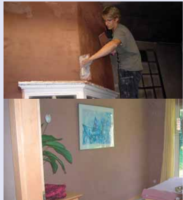
Aufbringen von Lehmputz oder Lehmputz natur
