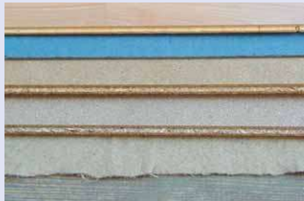
Fertigteilestrich mit Tannin-Spanplatten-Doppellage
