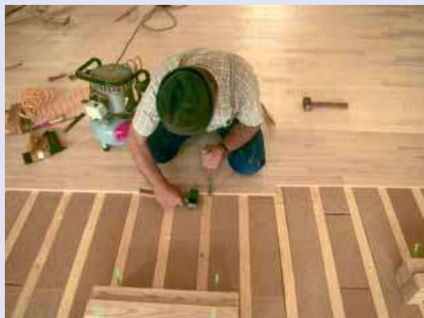
Lagerholzkonstruktion
