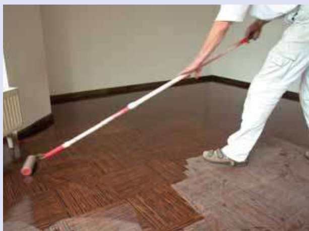
Der erste Ölauftrag wird in der Regel mit der Walze aufgetragen
